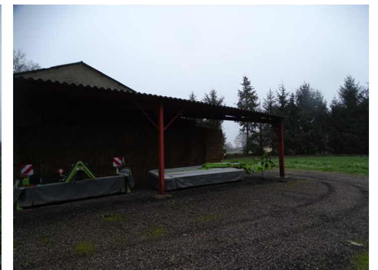
Bâtiment de stockage au droit du projet
