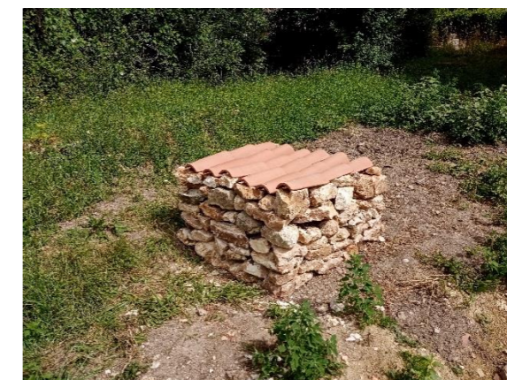
Photographie d’un pierrier type à réaliser
