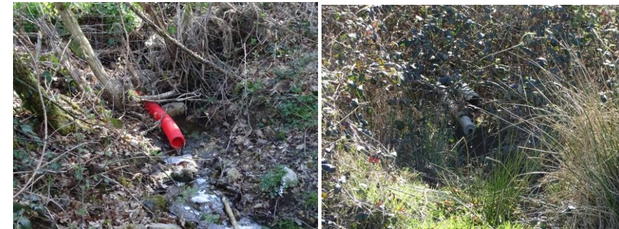
Figure 118 : Des drains ont été recensés au niveau du terrain
